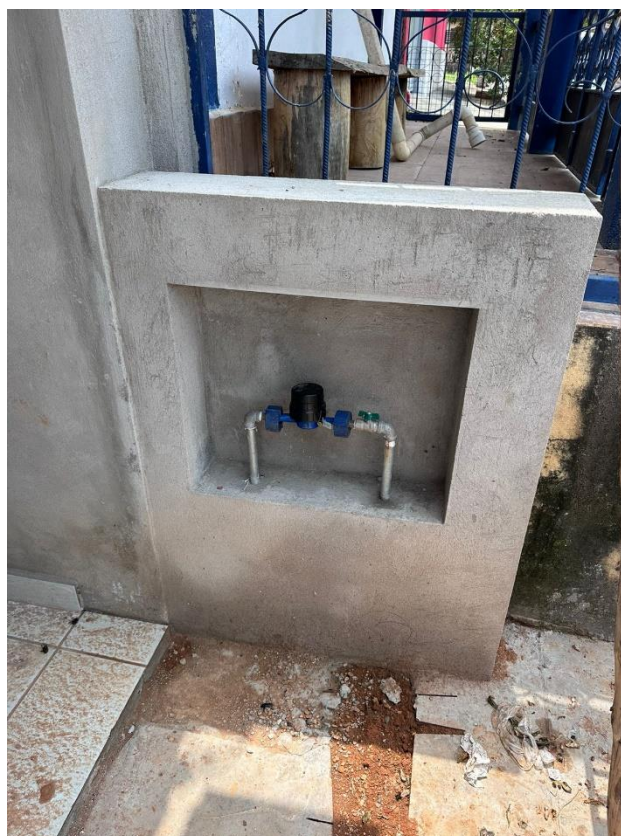
Foto 3: Instalação de hidrômetro.
