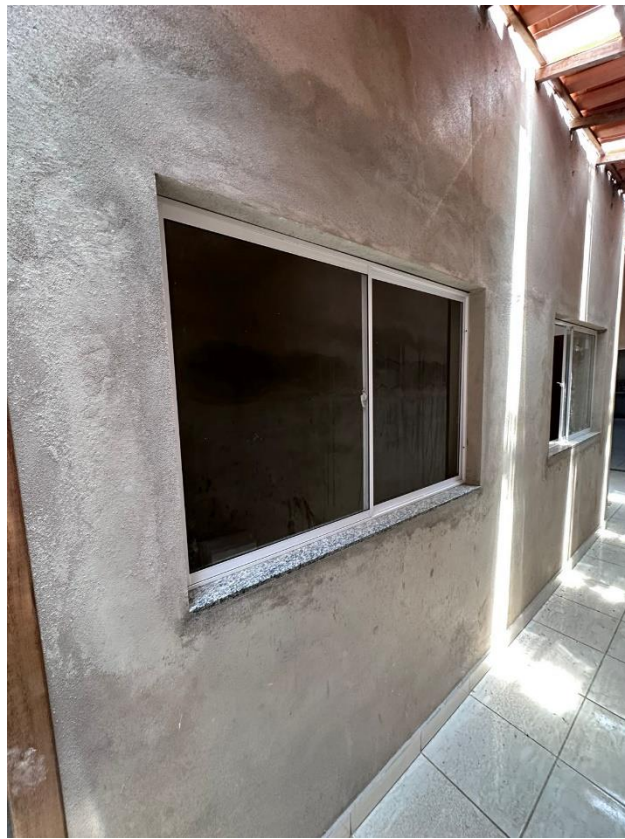
Foto 6: Assentamento de janela de vidro e peitoril.
