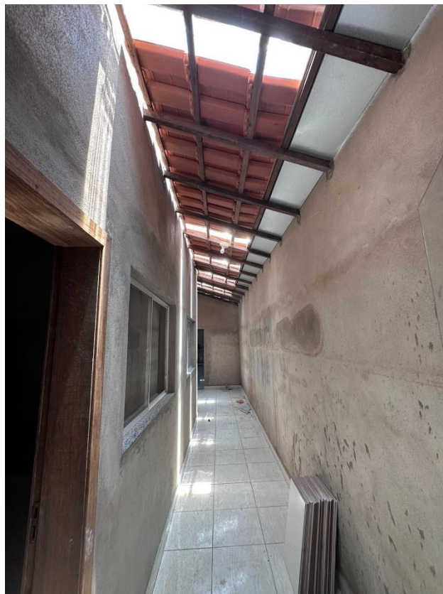
Foto 7: Telhado, calha e cerâmica.
