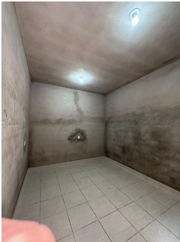
Foto 8: Instalação de tampas de caixinhas de elétricas e plafon.
