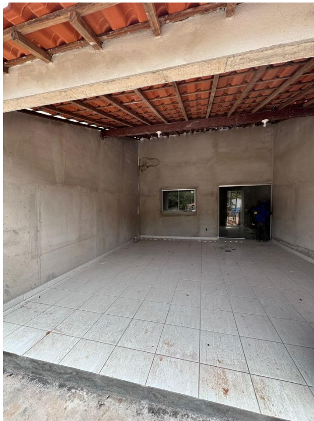
Foto 2: Cerâmica e telhado.
